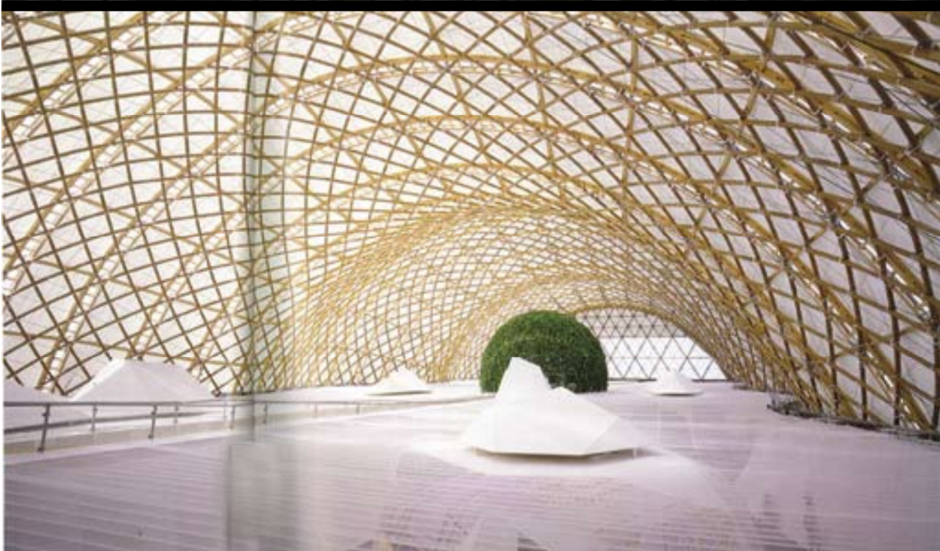
UN TEATRO DI TRADIZIONE GIAPPONESE/ Pietra miliare delle architetture di carta, il Theatre Dome di Shigeru Ban costruito a Utrecht, Olanda, nel 2003. Una struttura imponente e leggera in tubi di cartone che reinterpreta le costruzioni di bambù giapponesi.
